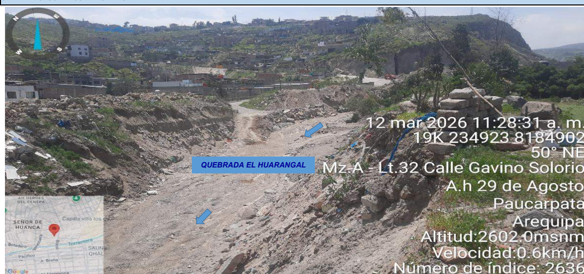
Imagen N° 1. Tramo colmatado en el sector Miguel Grau etapa 5, en donde se observa sedimentación en el cauce de la quebrada El Huarangal.
