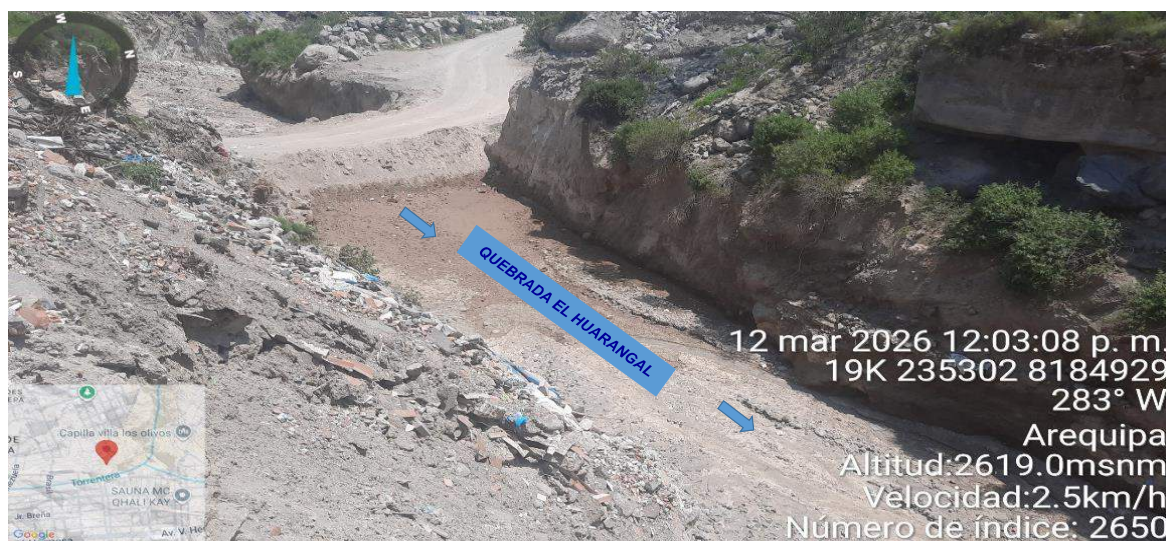
Imagen N° 2. Zona colmatada en el tramo, en donde se observa sedimentación en el cauce de la quebrada El Huarangal.
